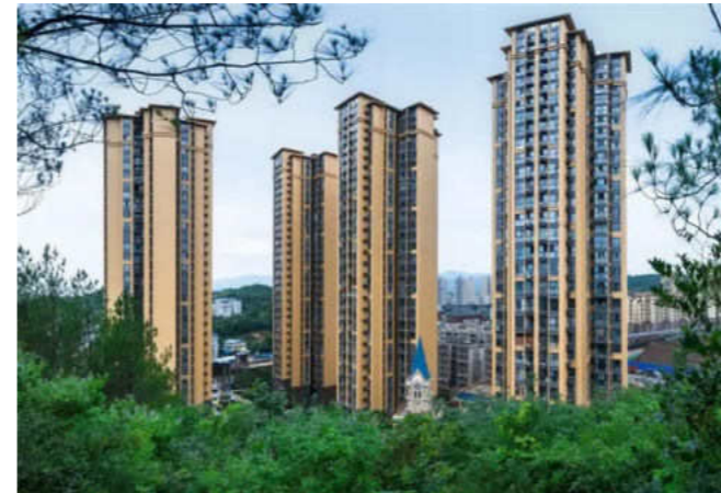
家庭住宅供水
