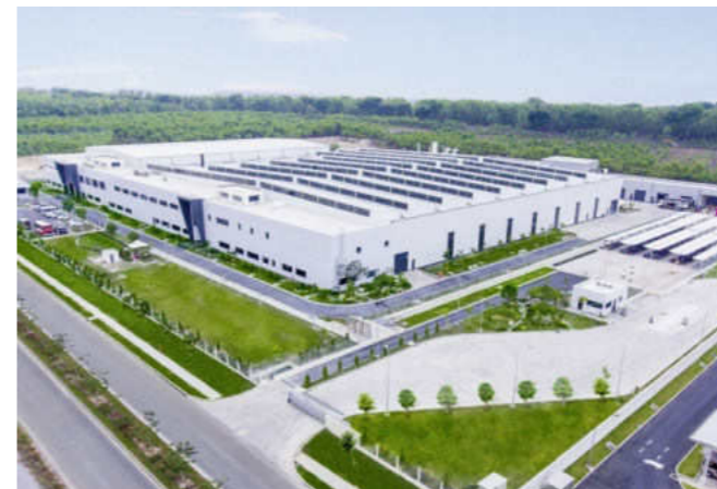
工厂场区供水
