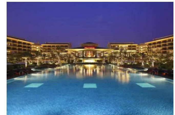
酒店建筑供水
