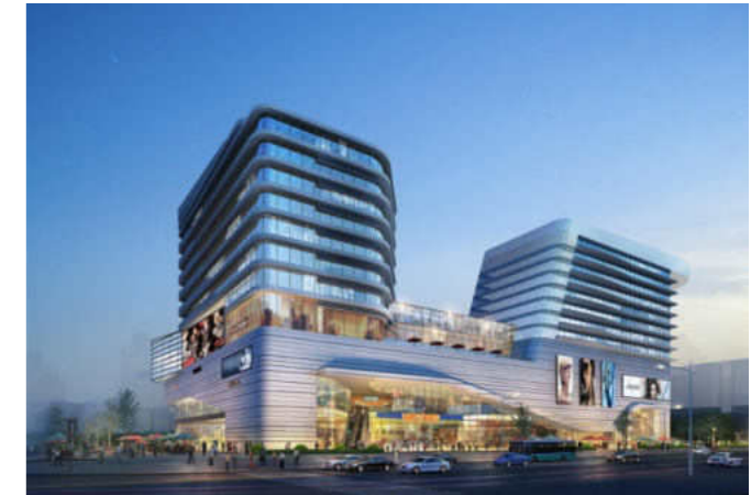
商用建筑供水
